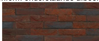
Metselwerk B Roodpaars Veranda- en rijwoningen (bouwnummers 138 t/m 141 en 146 t/m 149)
